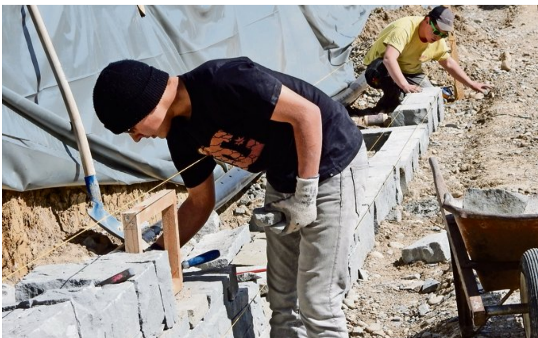
Dem Mauerbauer bei der Arbeit zusehen können Interessierte im Rebhang in der Nähe der Chräen-Anlage. Foto: PD
